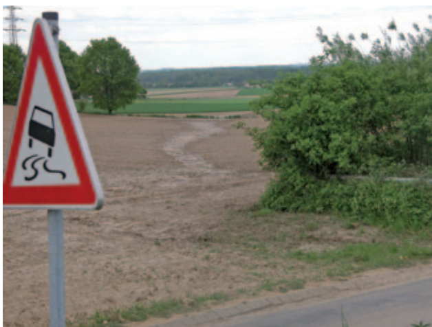
Abb. 11: Fremdwasserzufluss als Ursache für Bodenerosion. Das von einer Straße abfließende Wasser hat auf Ackerflächen in einer Tiefenlinie über mehrere Schläge hinweg Erosionsrinnen und -gräben ausgespült (Foto: Dr. habil. Dieter A. Hiller, Büro für Bodenschutzplanung).
